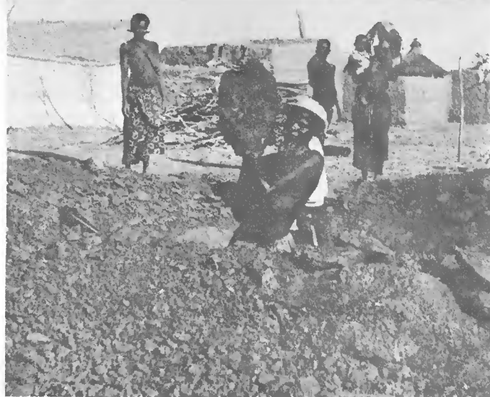
La latrine doit être creusée assez bien loin de la maison et des sources d'eau potable.
