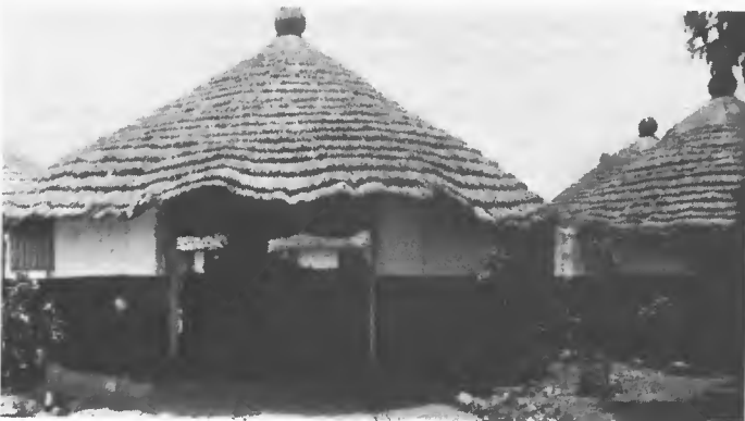
Constructions rurales à Niamtougou au Togo : des briques en terre stabilisée pour des cases plus durables et une plus belle finition.
