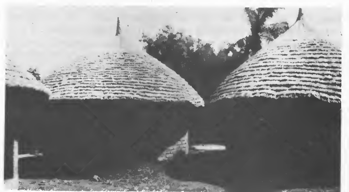
Constructions rurales à Niamtougou au Togo : des briques en terre stabilisée pour des cases plus durables et une plus belle finition.
