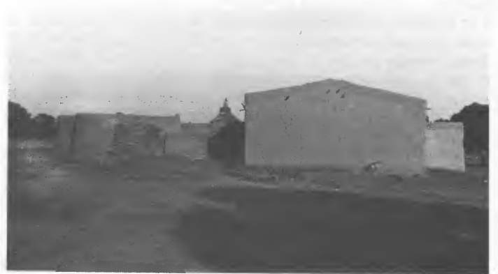
Constructions rurales chez les Gourounsi du Burkina Faso : la réduction de la main-d'œuvre disponible pour le façonnage direct a imposé les briques en terre crue et les cases rectangulaires.
