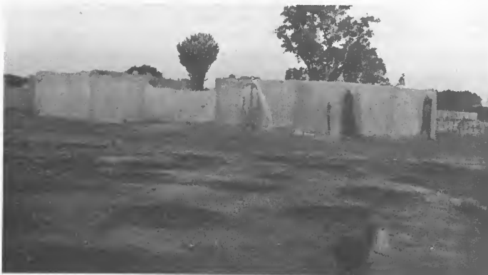
Constructions rurales chez les Gourounsi du Burkina Faso : la réduction de la main-d'œuvre disponible pour le façonnage direct a imposé les briques en terre crue et les cases rectangulaires.
