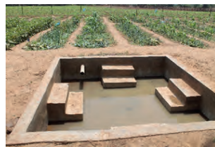
Bassin construit sur un des sites
