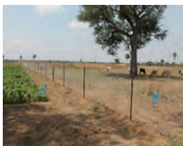
Clôture de site à l'aide d'un grillage
