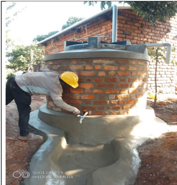
Installation des collecteurs d'eau des pluies à Manege en commune Murwi.
