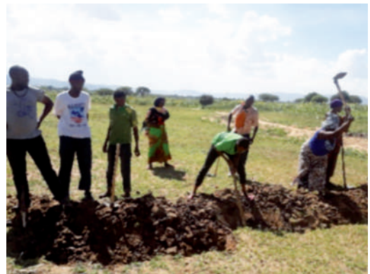
Le labourage en profondeur permet de briser ces sols compacts pour faciliter l'infiltration des eaux pluviales.
