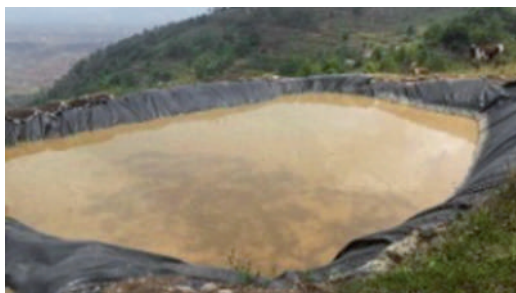
Barrage avec revêtement et recueil d'eau
