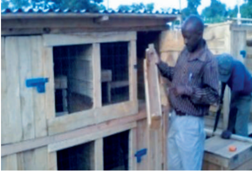
Poulaillers fabriqués à partir de matériaux locaux
