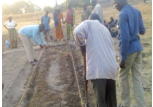
Une formation sur la construction de planches pour les cultures
