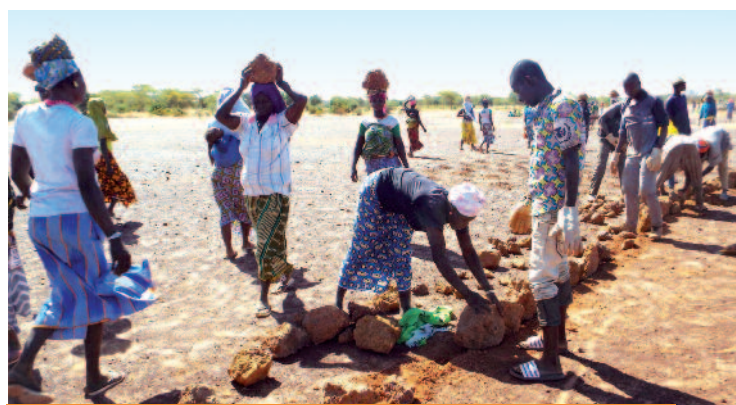
Pour restauration des terres dégradées, Inades-Formation Burkina accompagne des communautés de certaines zones arides de la région du Nord du Burkina dans la réalisation de cordons pierreux.
