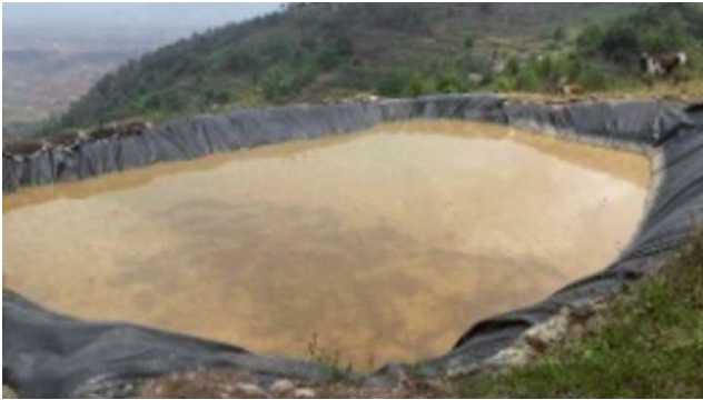
Barrage avec revêtement et recueil d'eau
