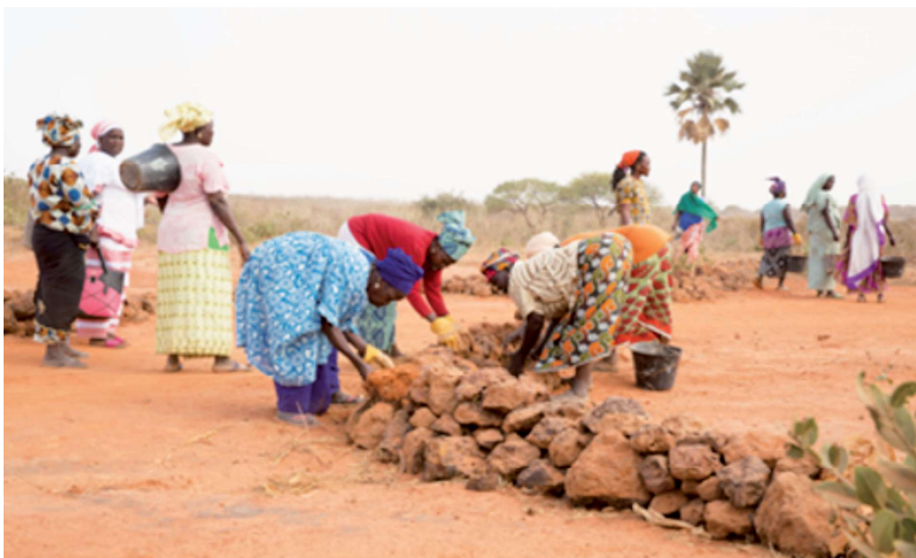
Aménagement de demi-lune pour favoriser l'infiltration des eaux et la conservation de l'humidité dans le sol autour des arbres
