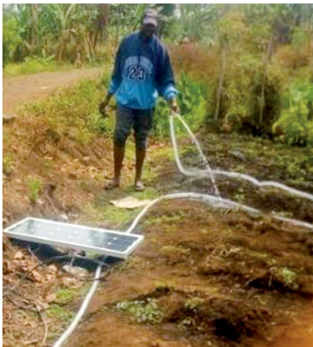
Arrosage à l'aide d'une pompe solaire
