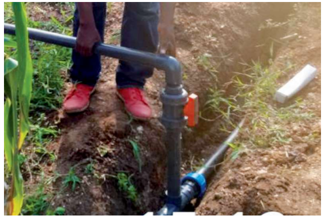
Installation de tuyaux PVC pour l'acheminement de l'eau climatique ;
