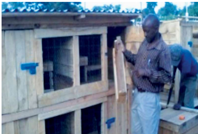
Poulaillers fabriqués à partir de matériaux locaux
